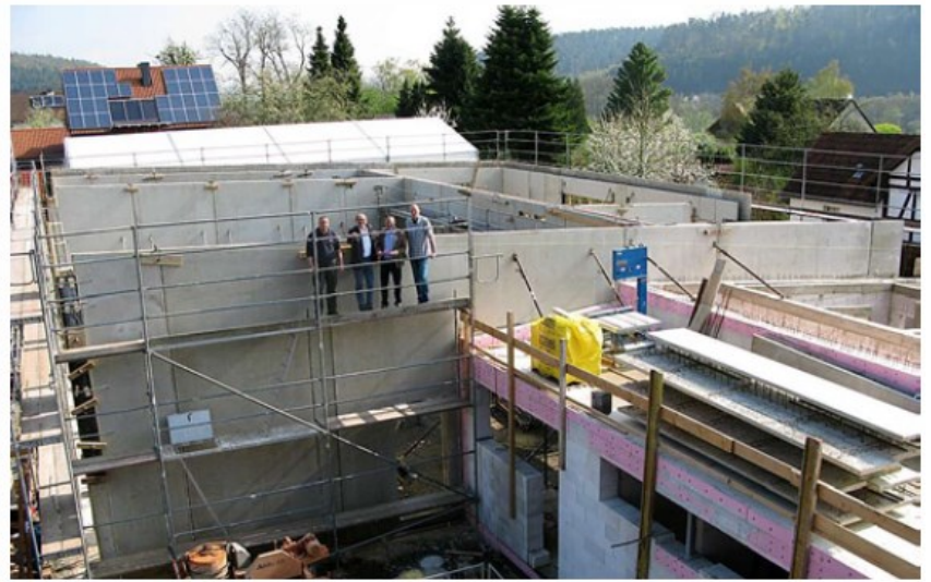
Martin Wilhelm (von links) Roland Ott, Volker Carle und Jörg Weber begutachten den Baufortschritt der Fahrzeughalle für die Feuerwehr Cölbe.
